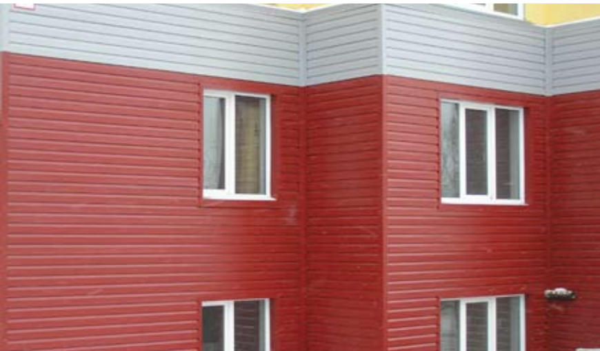
На фото: г.Барнаул, жилой дом по ул.Малахова. Устройство кровли из металлочерепицы, облицовка нижних этажей сайдингом, изготовление и монтаж козырьков.
