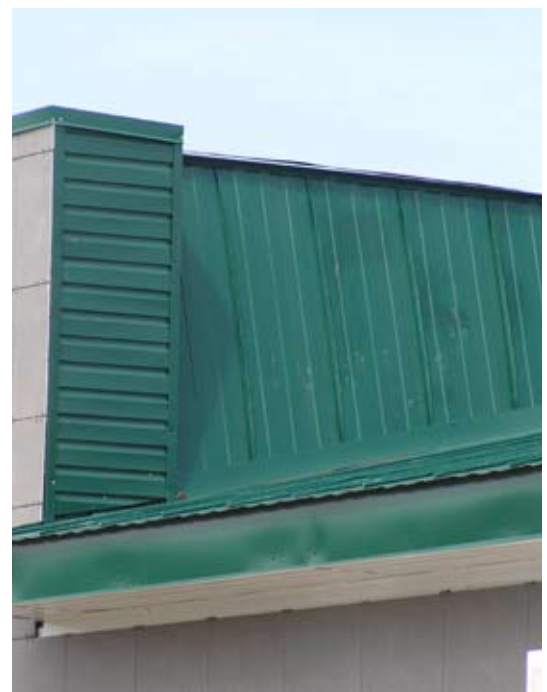
На фото: г.Змеиногорск, здание Сберегательного Банка РФ. Устройство фальцевой кровли, облицовка фасадов керамогранитом с утеплением.
