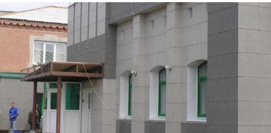
На фото: г.Змеиногорск, здание Сберегательного Банка РФ. Устройство фальцевой кровли, облицовка фасадов керамогранитом с утеплением.
