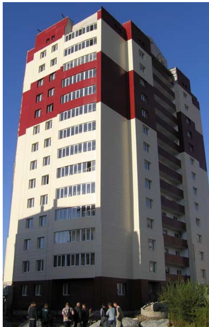
На фото: г.Бийск, здание ТОМ «Приобский» УВД г.Бийска. Облицовка фасадов металлосайдингом. г.Барнаул, жилой дом по ул.Малахова. облицовка фасадов металлосайдингом. г.Бийск, производственный цех. Изготовление и монтаж металлоконструкций, монтаж сэндвич панелей, оконных витражей.
